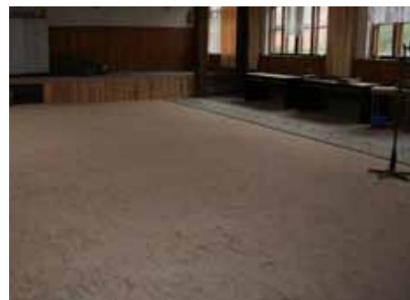
Remont świetlicy w Kwietniewie, fot. A. Kulma
