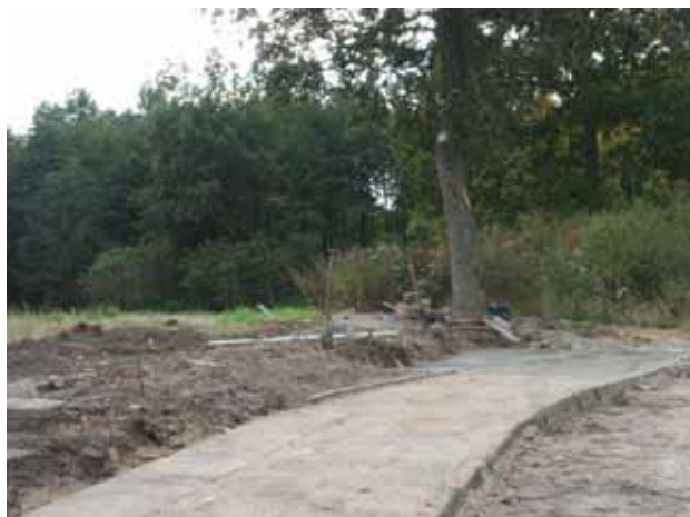
Prace pod wymianę wiaty przystankowej w Jankowie, fot. A. Kulma
