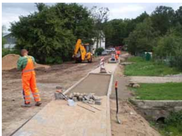
Budowa chodnika w Dymniku, fot. R. Cytrycki
