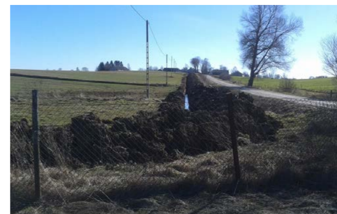
Prace przy budowie wodociągu w Lepnie, fot. R. Cytrycki
